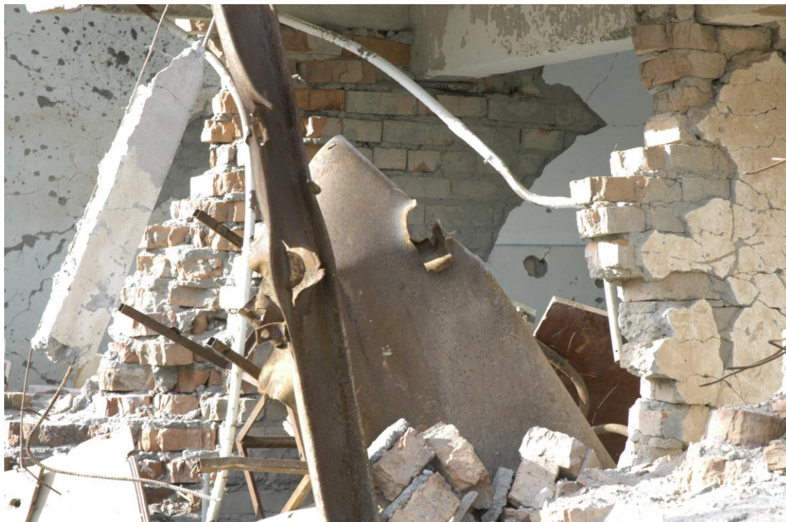
Рис. 24. Сквозные пробоины в металлической балке (к рис. 45).
