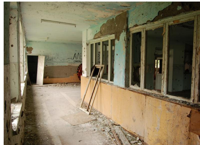
Рис. 89. Коридор первого этажа восточного крыла школы.
