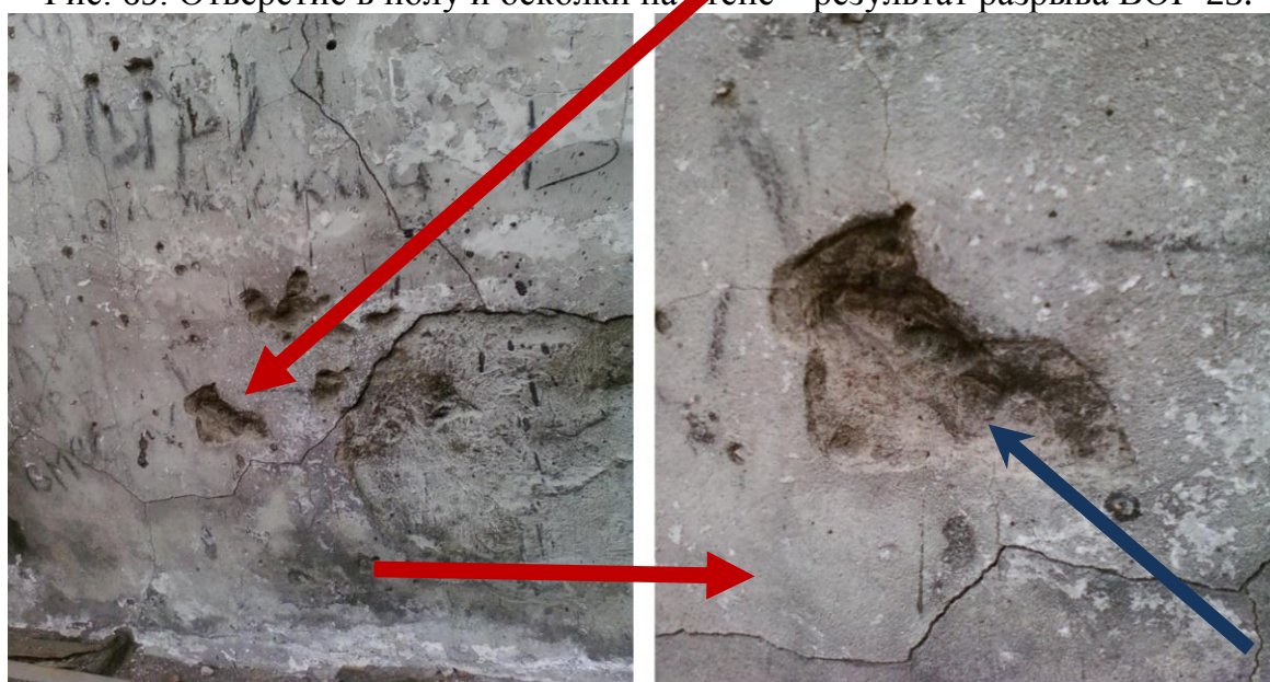
Рис. 70. Осколки на стене имеют чётко выраженное направление углубления.
