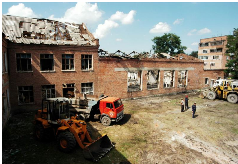
Рис. 90. Вид со второго этажа западного крыла школы.
