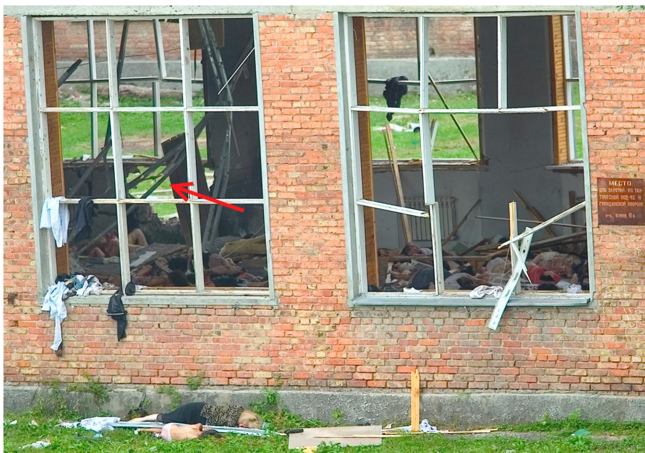
Рис. 74. Стрелкой указан пролом в стене спортивного зала под окном.
