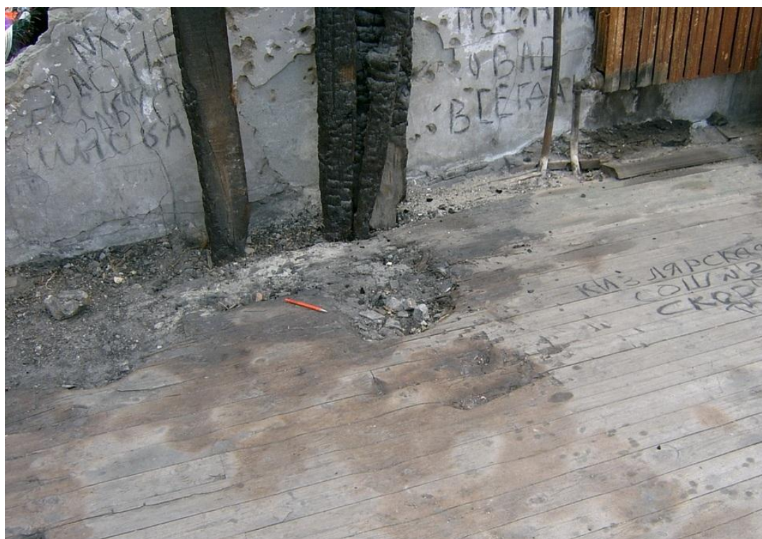
Рис. 75 в. Пролом в стене спортивного зала под окном. Локализация осколков.
