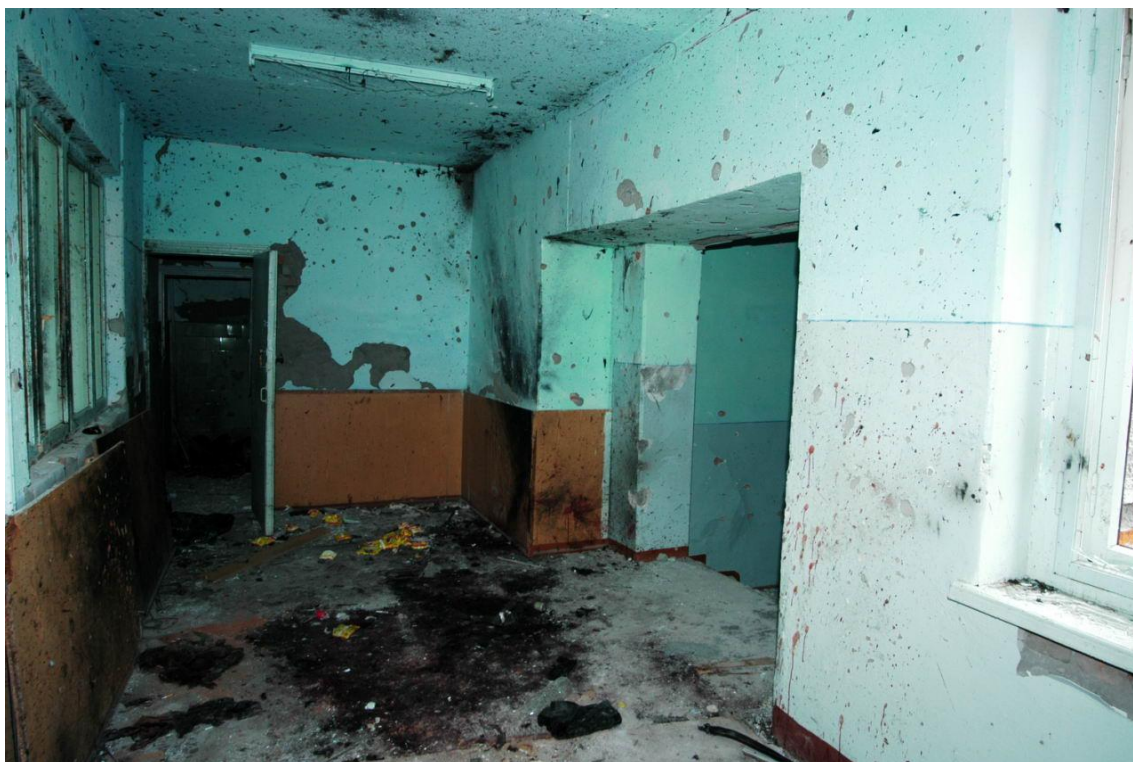
Рис. 92. Коридор первого этажа восточного крыла школы.
