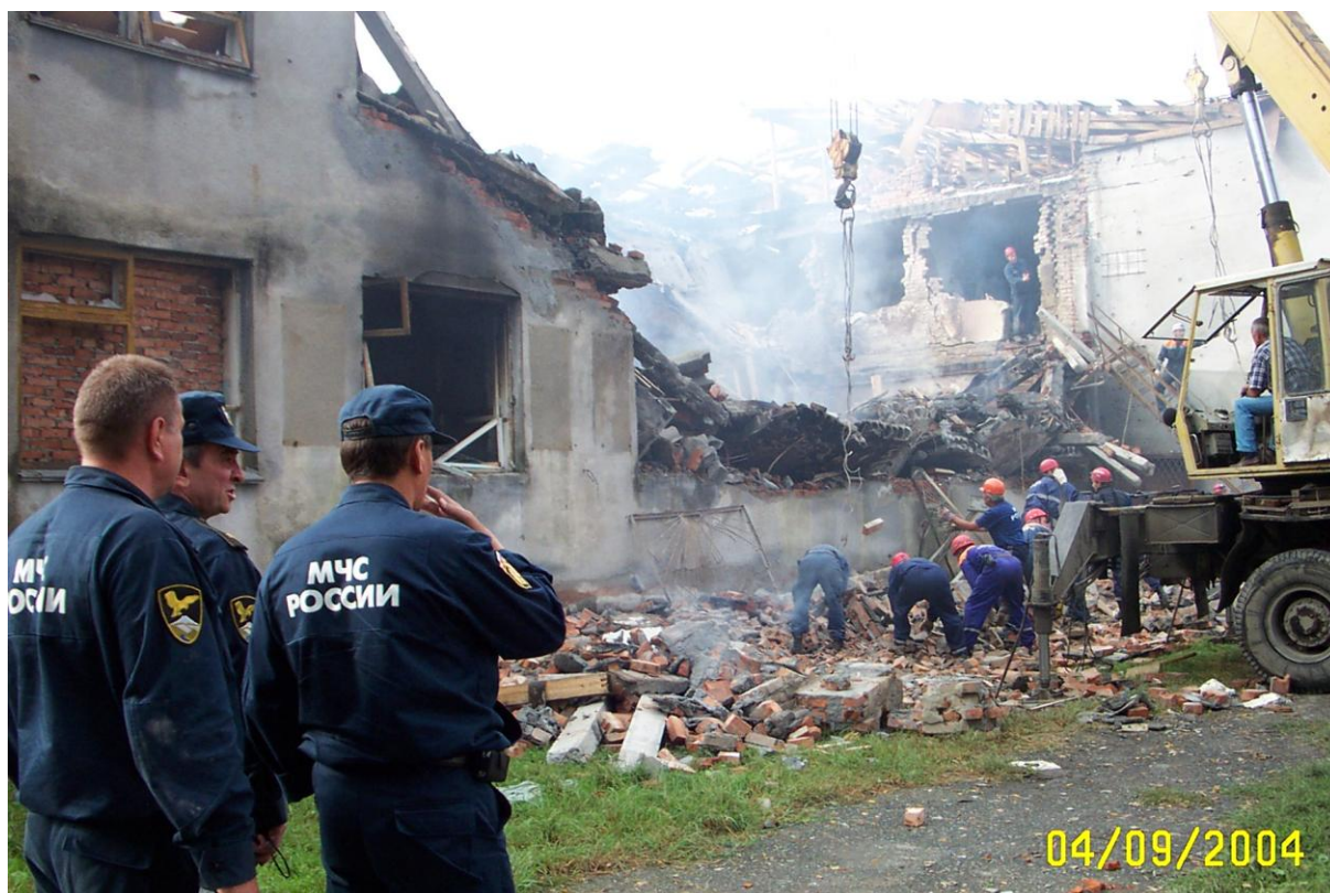
Рис. 41. Разрушения, якобы вызванные «накладным» взрывом, применённым для уничтожения террористов, скрывающихся в «подвале».
