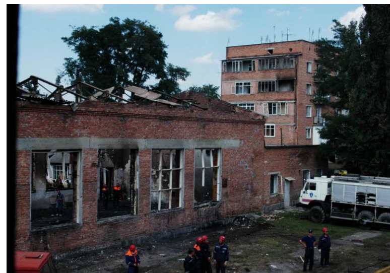
Рис. 91. Вид со второго этажа западного крыла школы.
