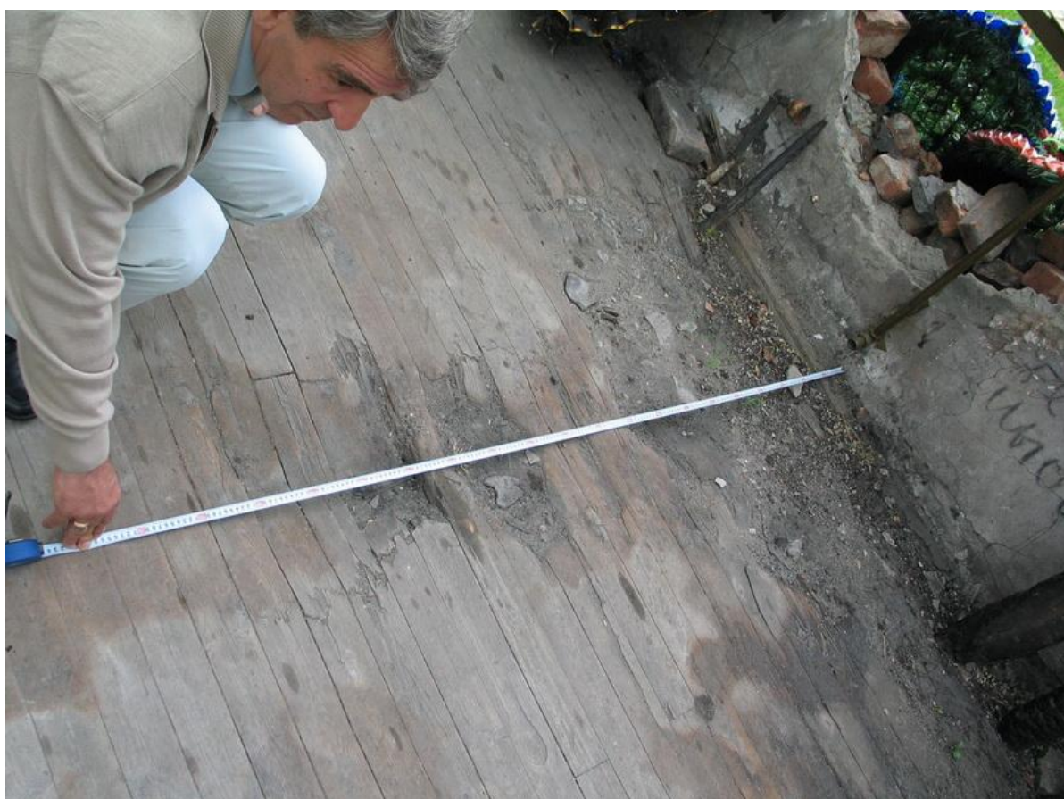
Рис. 82. Разрушения пола в месте «второго взрыва» (в т.ч. СВУ типа «чемодан») по версии экспертизы математического моделирования.
