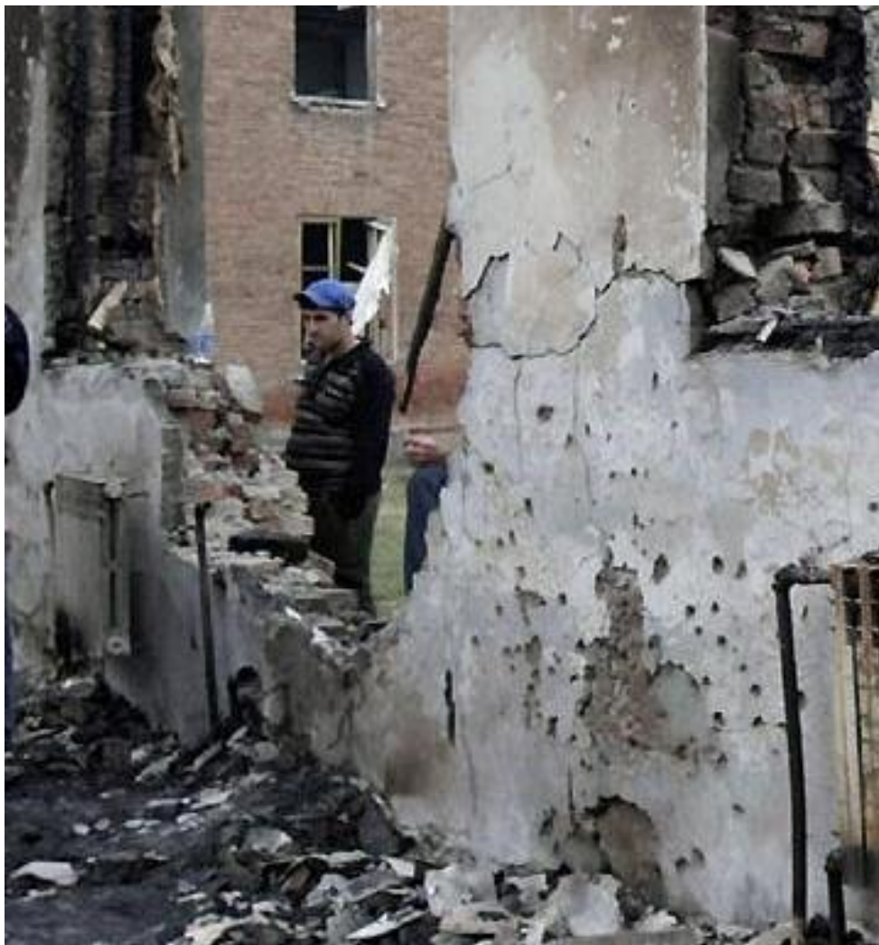
Рис. 75 в. Пролом в стене спортивного зала под окном. Локализация осколков.
