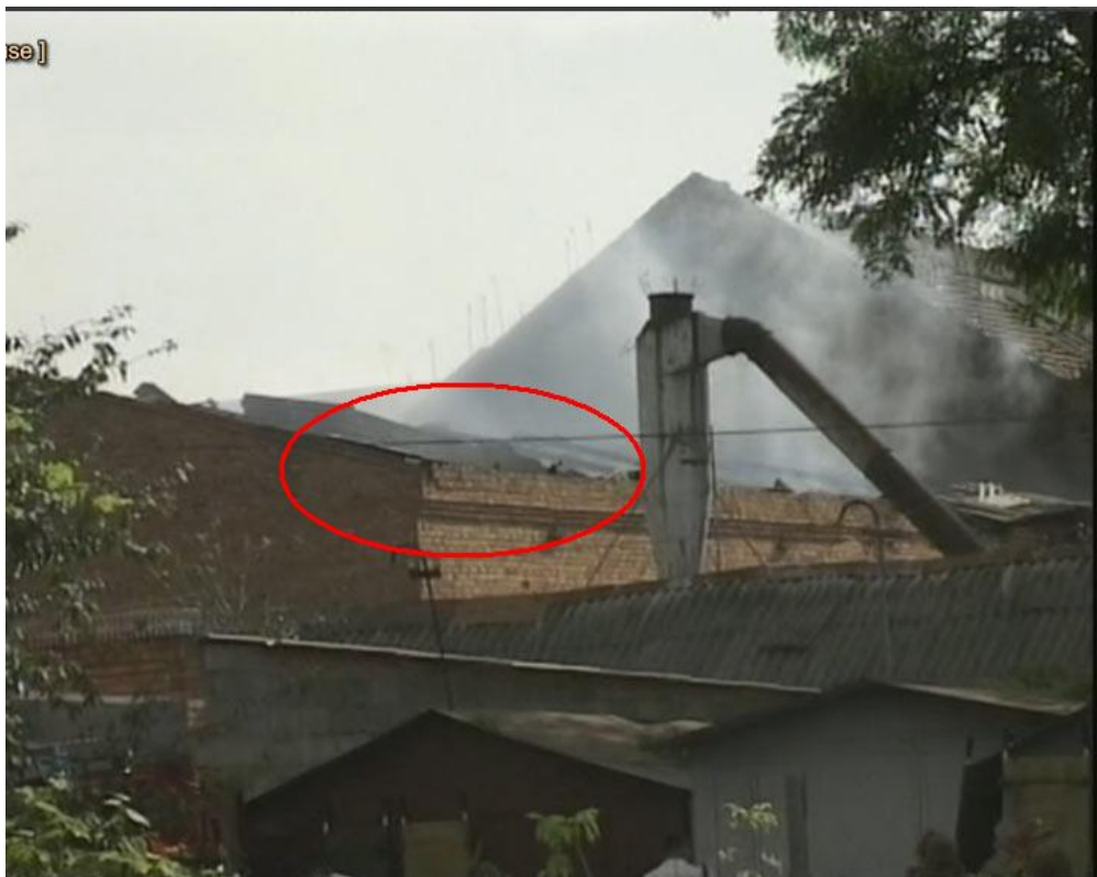
Рис. 79. Горизонтальный сдвиг кирпичей верхнего ряда.
