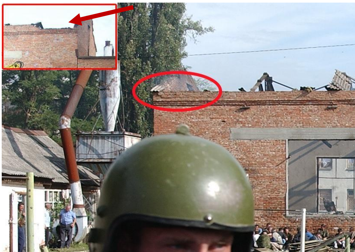
Рис. 78. Горизонтальный сдвиг кирпичей верхнего ряда и отсутствие кирпичей с другой стороны спортивного зала.
