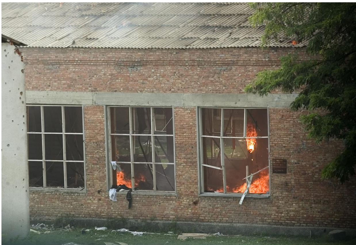
Рис. 77. Отсутствие разрушений шифера на южном скате крыши.
