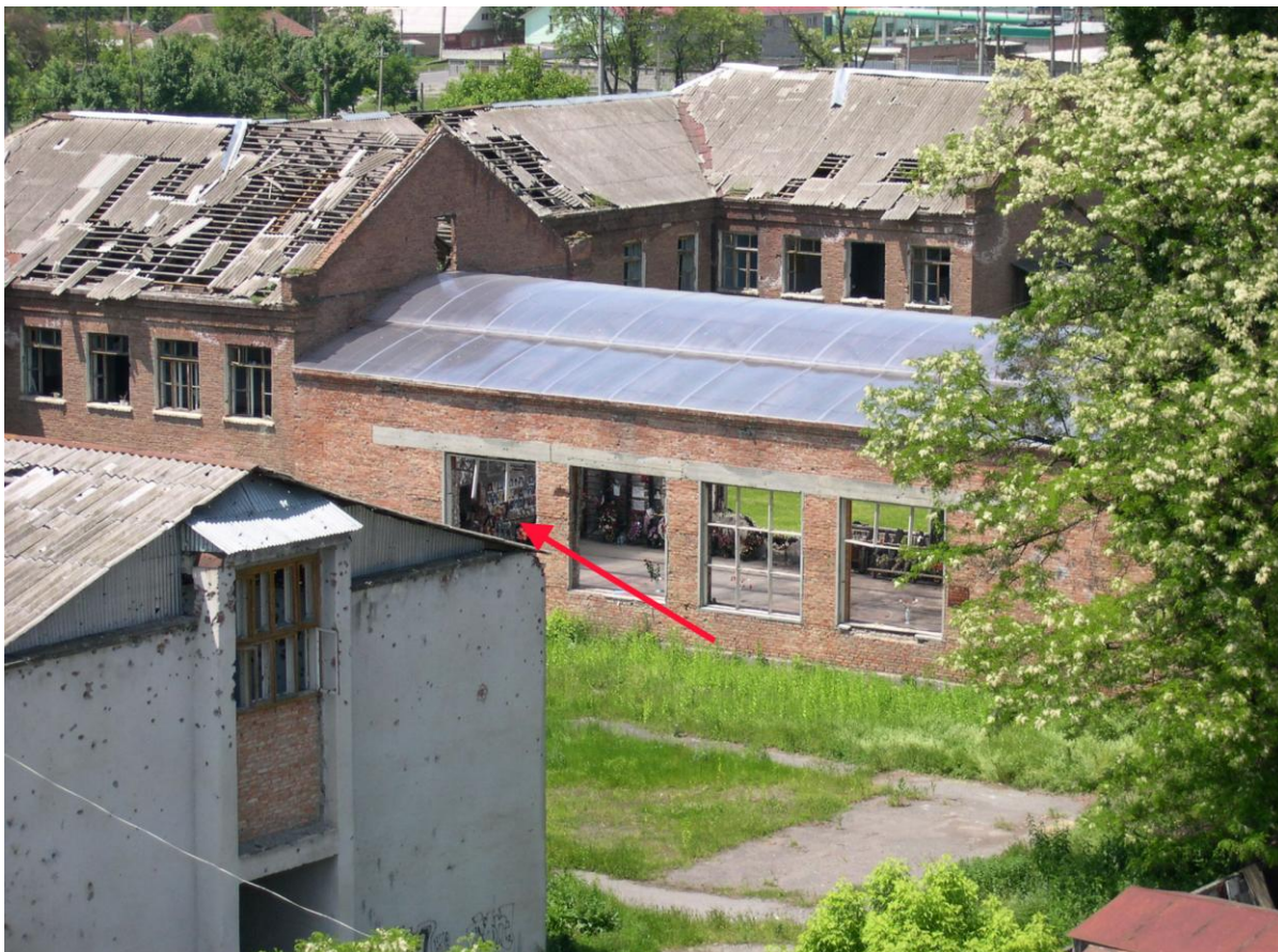
Рис. 64. Вид на спортзал с крыши дома № 41 по пер. Школьному.
