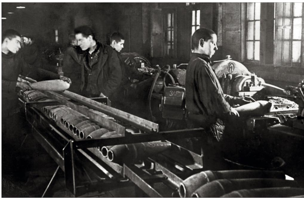
Производство корпусов 120-мм мин
