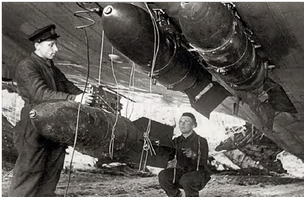
Подвеска 500-кг фугасных авиабомб под самолет
